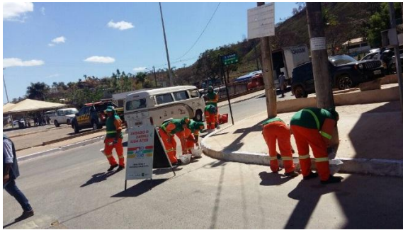
Pintura de meio fio
